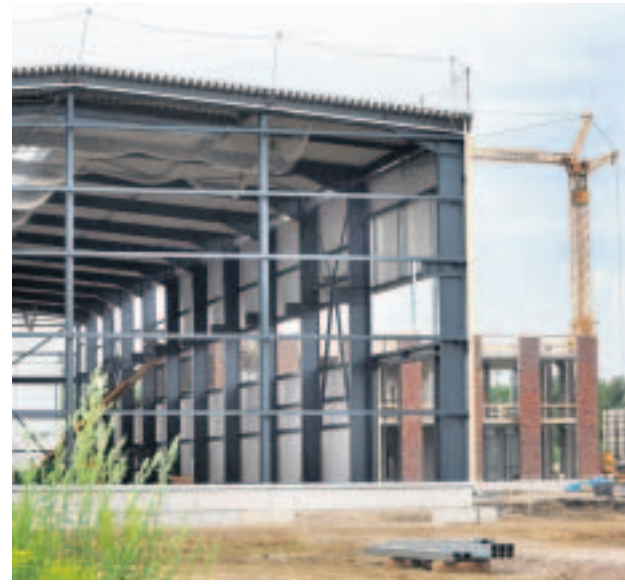
Der neue Firmensitz im Hafen wächst. Zum Jahresende will die Stahlhandelsgesellschaft in den Neubau ziehen. Foto: Martin Möller
