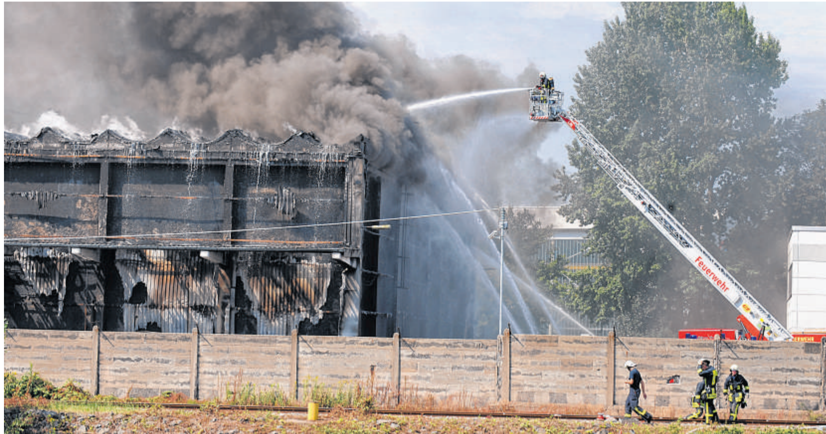
Grauschwarzer Rauch quoll in dicken Wolken aus der brennenden Halle. Das Feuer beschäftigte die Einsatzkräfte bis in den Abend.
