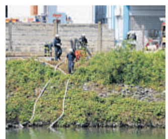
Aus dem nahen Hafenbecken wurde Löschwasser gepumpt.
